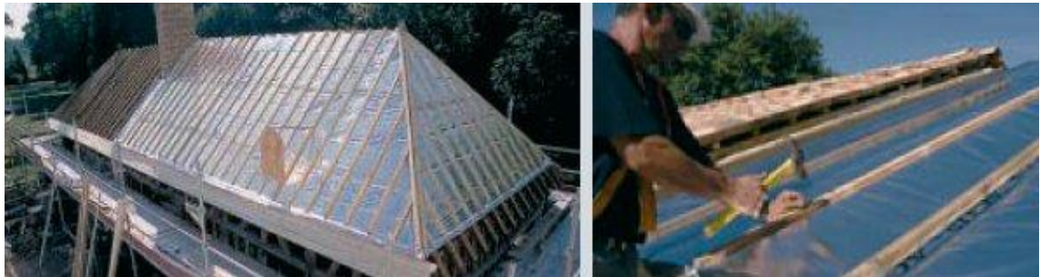
Figur 2.6 Reflekterande isolering på hustak
