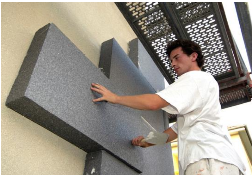
Figur 2.4 Grafit cellplast som placeras på fasad
