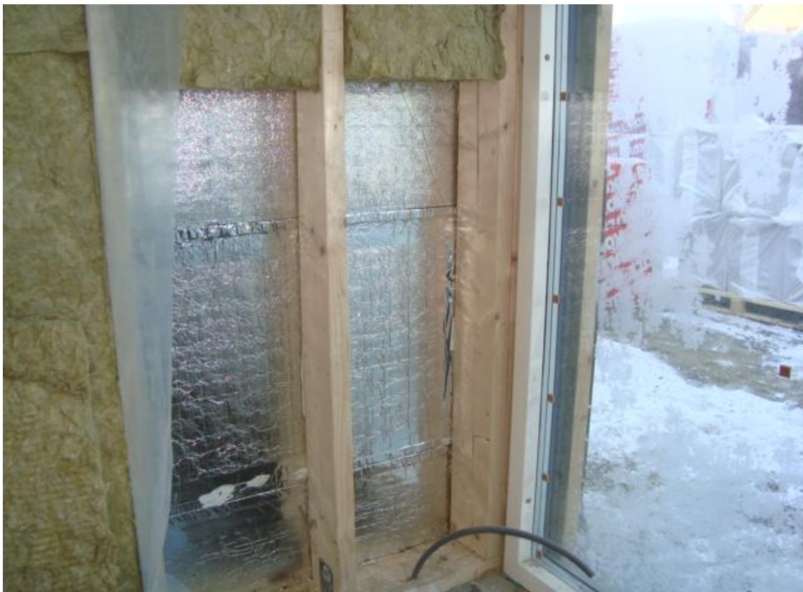
Figur 4.2 Utfackningsvägg med vakuumisolering
